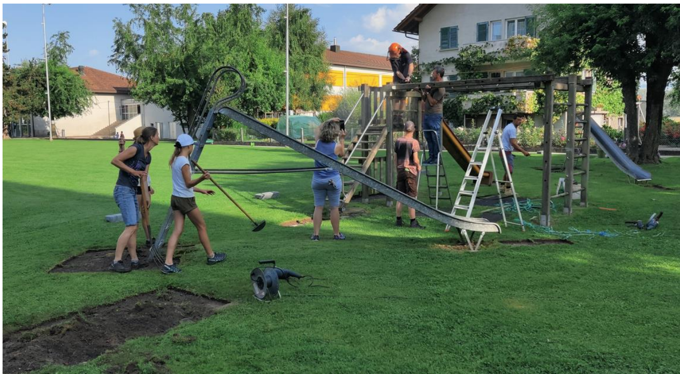
Abbildung 21: Kinder und Eltern helfen mit beim Rückbau
